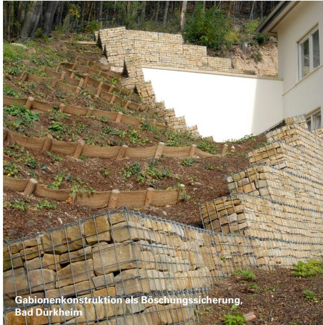
Gabionenkonstruktion als Böschungssicherung,
