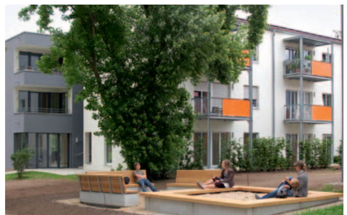
Experimenteller Wohnungsbau – Modernisierung und Ergänzung (Nürnberg)
