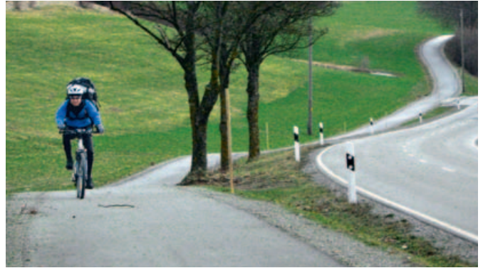
Geh- und Radweg an der Staatsstraße 2009 zwischen Altusried und Kimratshofen
