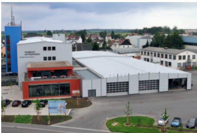
Städtebauförderung – Neunutzung Porzellanbrache als Gewerbetank und Museum (Mitterteich)
