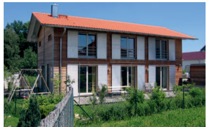
Wohnraumförderung – Einfamilienhaus (Landkreis Landshut)
