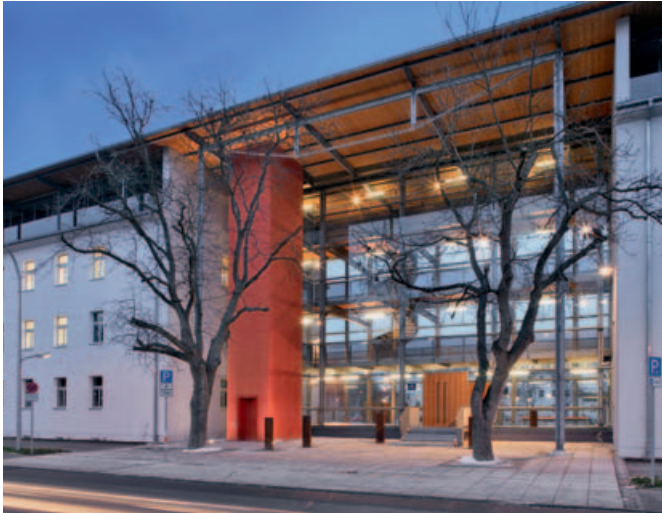
Polizeiinspektion mit Außenaufzug (Neu-Ulm)
