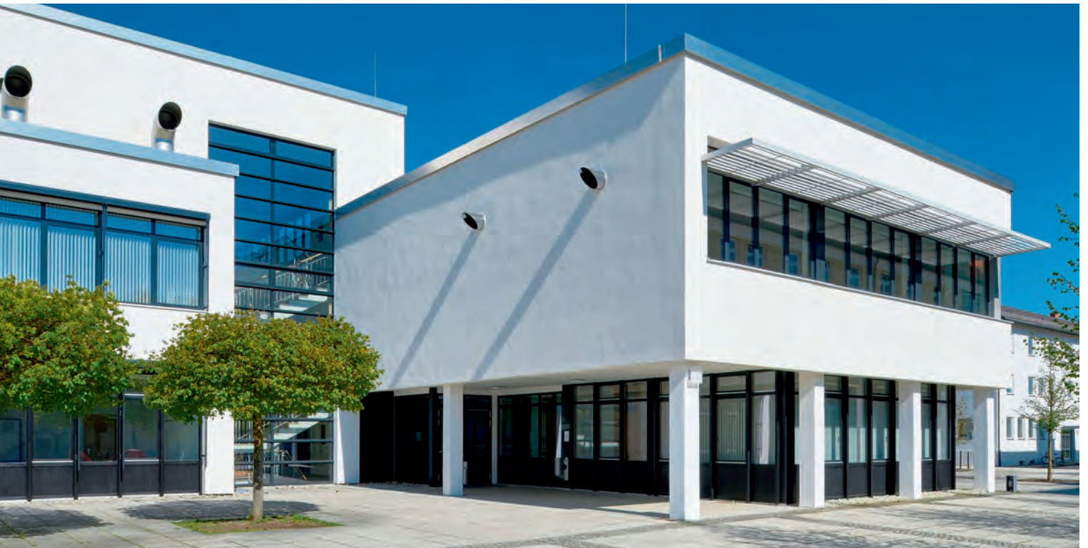
Energetische Sanierung Hochschule für angewandte Wissenschaften Landshut
