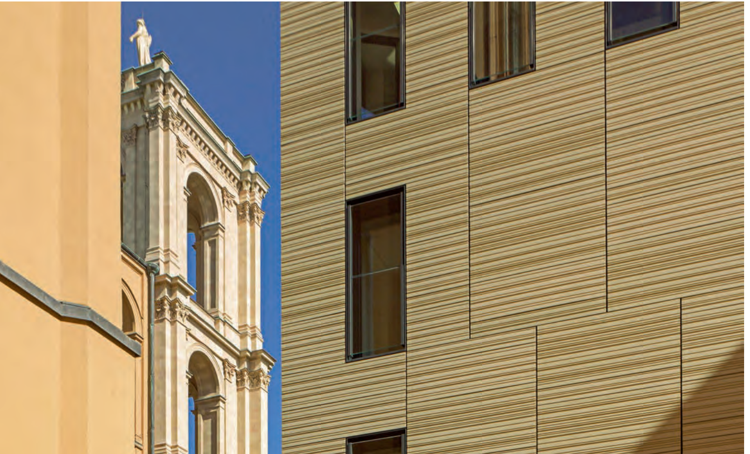
Fassade des Erweiterungsbau im Nordhof
