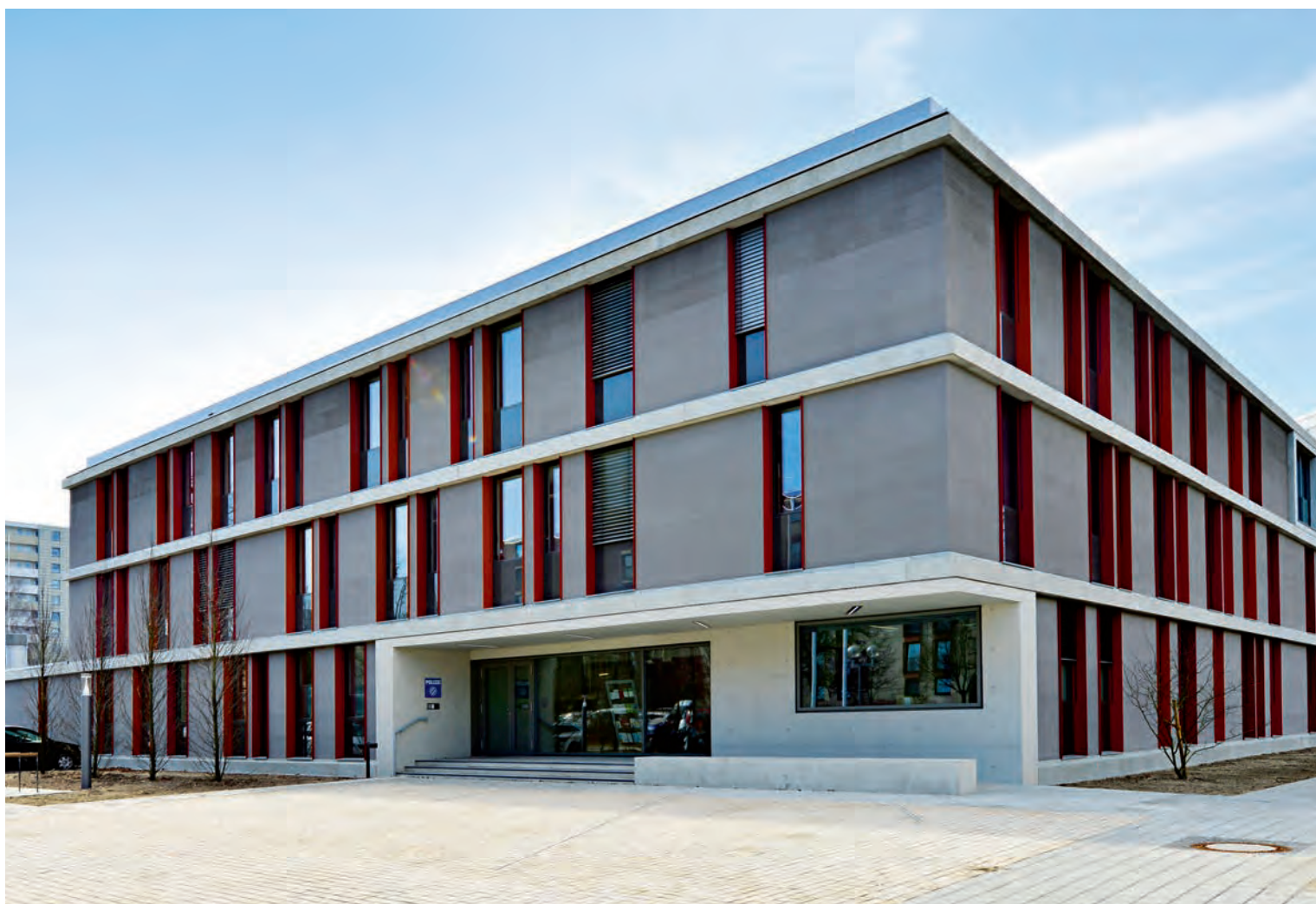
Westansicht der Polizeiinspektion
