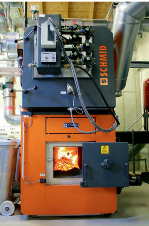
Hackschnitzelheizung in der JVA
