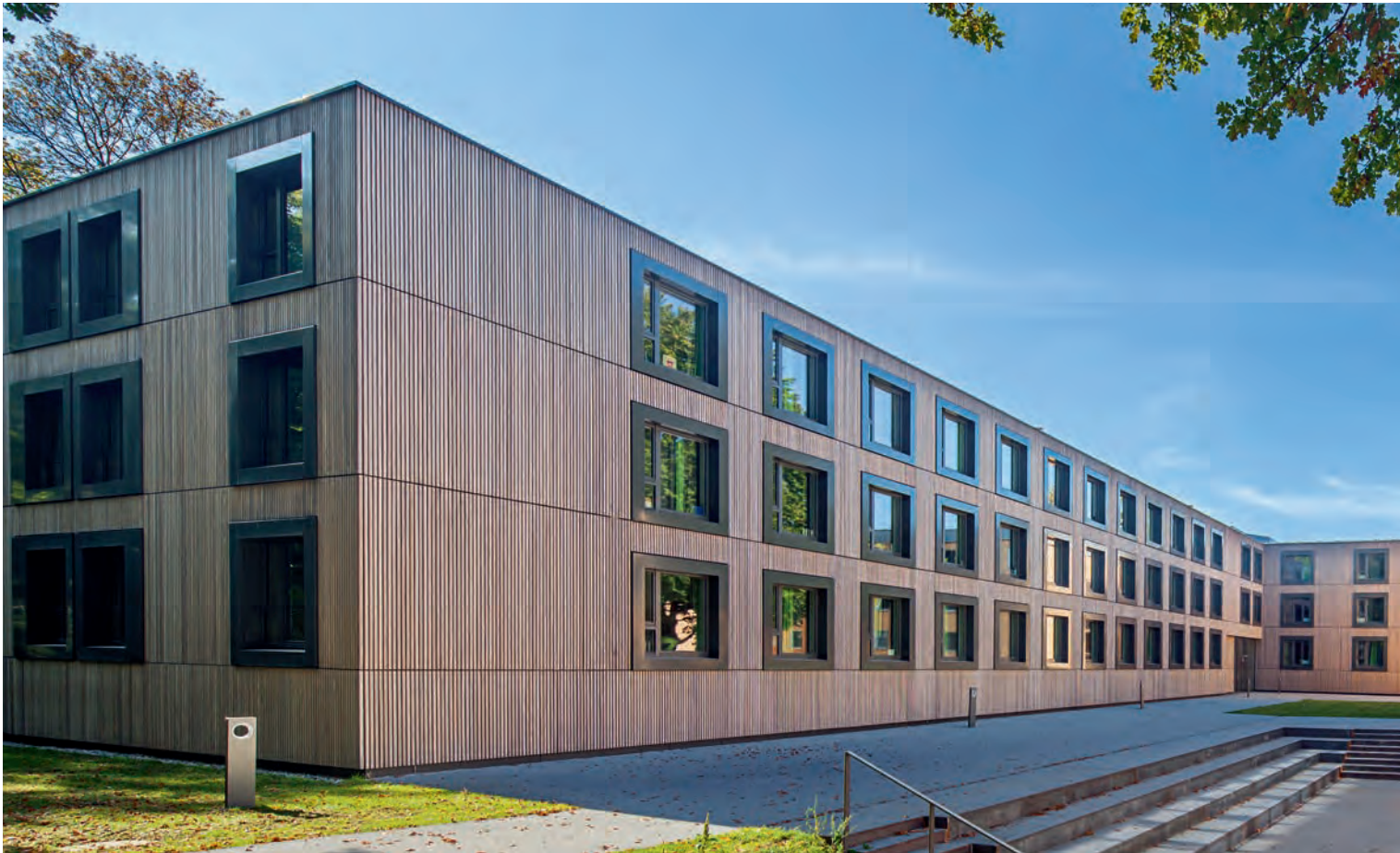
Neubau des Unterkunftsgebäudes
