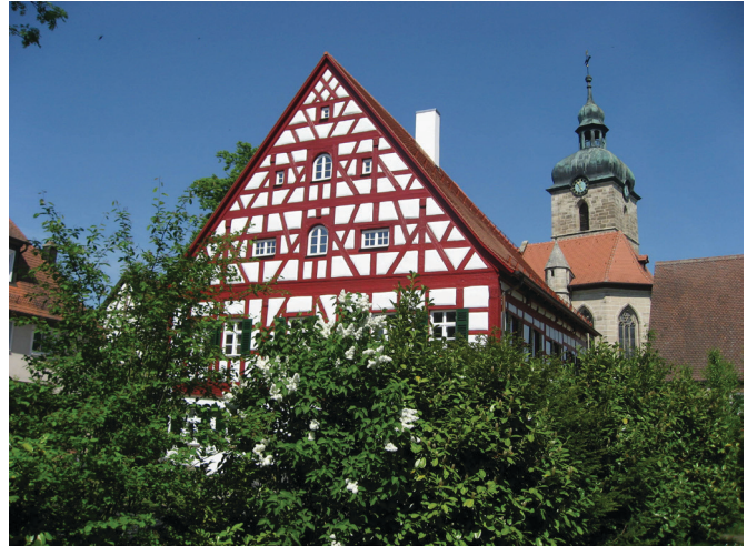
Ostfassade des Rangau-Museums
