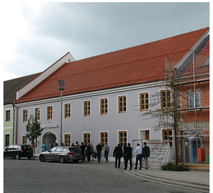
Ehemaliger Gasthof Post mit Postsaal nach der Sanierung
