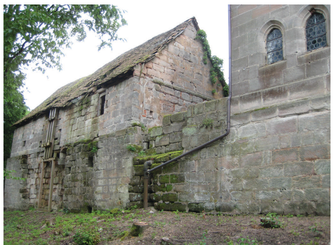
Schlossgraben und -stadel Pyrbaum vor der Sanierung
