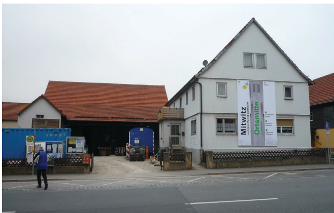
leerstehendes Anwesen vor der Sanierung
