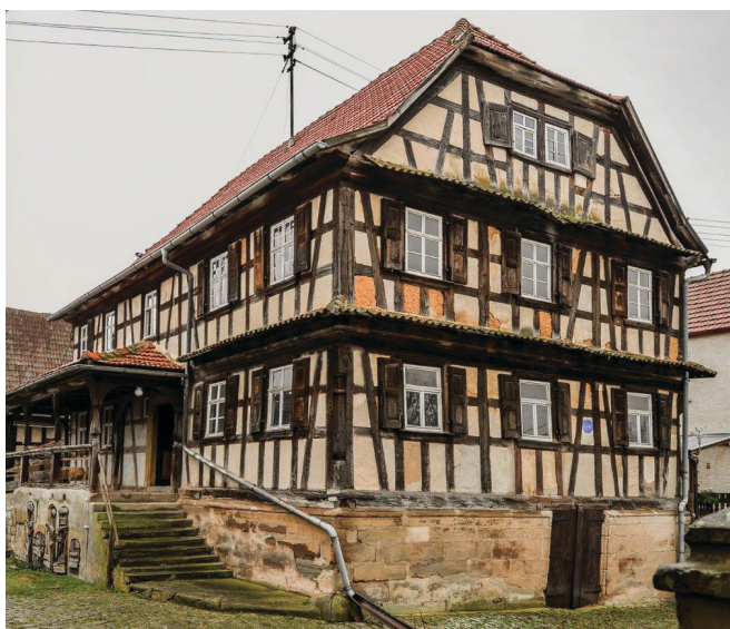
privates Bauvorhaben in Rügheim, vor der Sanierung
