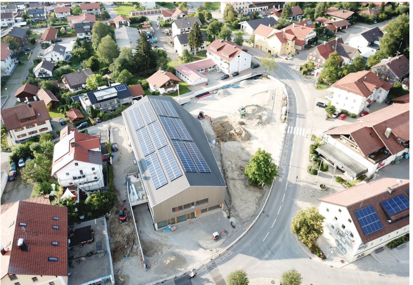
Baustellenfoto Nahversorger und neue Ortsmitte Buchenberg
