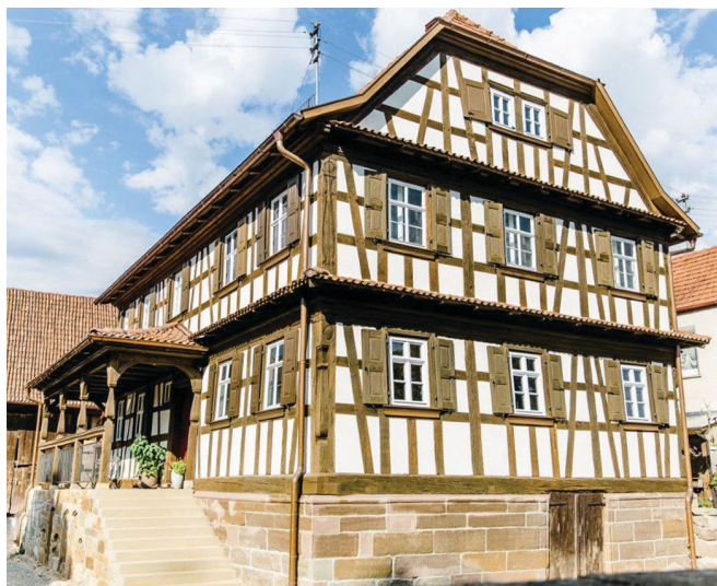
privates Bauvorhaben in Rügheim, nach der Sanierung
