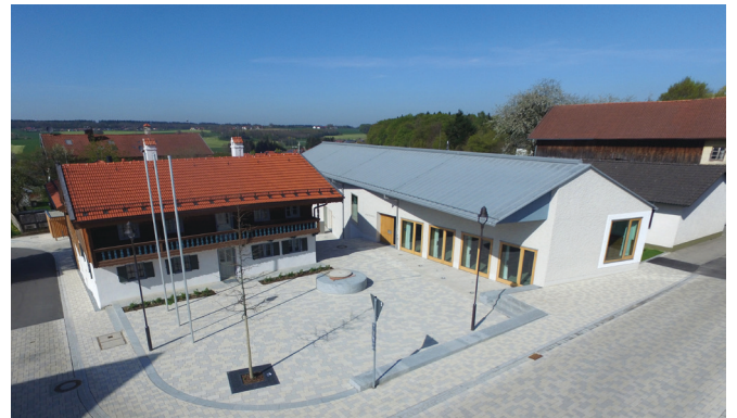
Neue Ortsmitte Maitenbeth (links Alte Post, rechts neues Rathaus)
