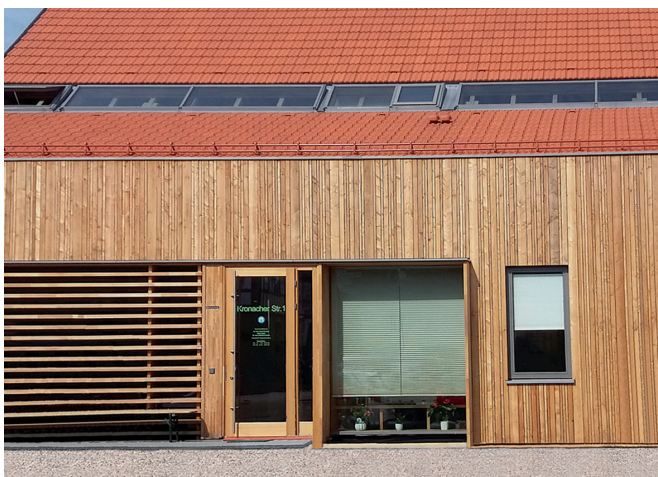
Eingangsfassade Arztscheune nach Sanierung
