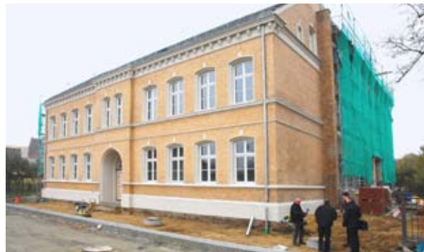
Vetschau; Sanierung des ehemaligen Gymnasiums/ Umbau zum Bürgerhaus; Quelle: Stadt Vetschau
