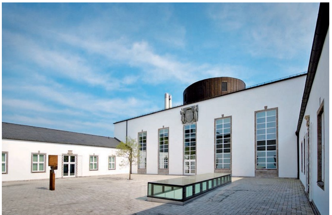
Die Kunsthalle Schweinfurt hat in den charakteristischen Räumen des ehemaligen Ernst-Sachs-Bad einen attraktiven Standort gefunden und trägt entscheidend zur Belebung der Innenstadt bei.
