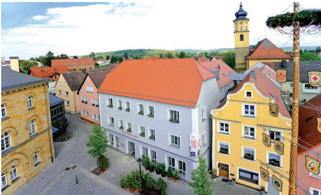
Für das neue Radlerhotel in Wassertrüdingen wurde ein leerstehendes Gebäude am Marktplatz umgenutzt. Das Projekt stärkt die touristische Entwicklung der gesamten Region Hesselberg.
