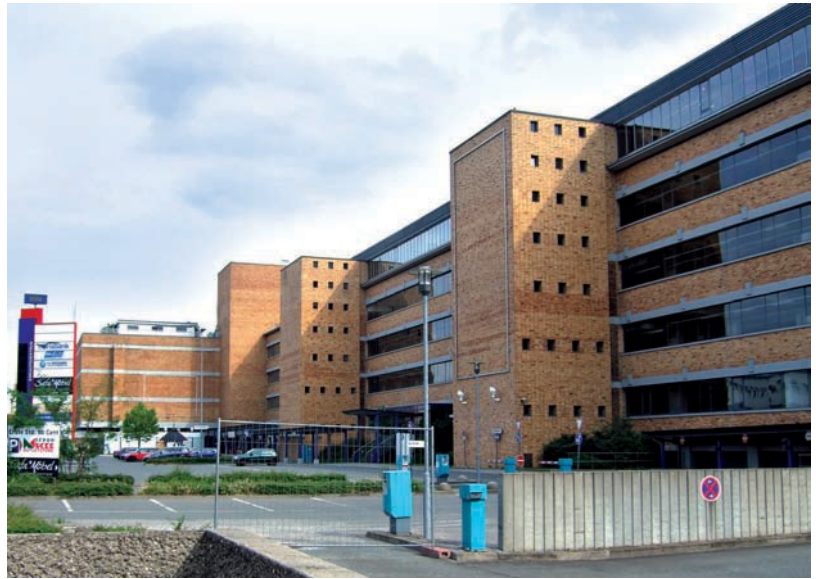
Das Quelle-Versandzentrum steht wegen seiner herausragenden architektonischen Qualität unter Denkmalschutz. Ideen für eine Umnutzung und die Gestaltung der umliegenden Flächen wurden in einem städtebaulichen Wettbewerb entwickelt.
