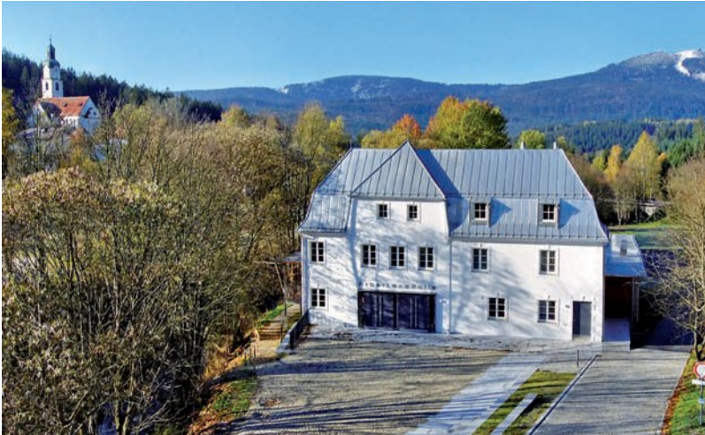
Für die Arberlandhalle in Bayerisch Eisenstein wurde ein ehemaliges Sägewerk umgenutzt und baulich ergänzt. Die Halle bietet kulturelle Angebote für die Bewohner von beiden Seiten der Grenze.
