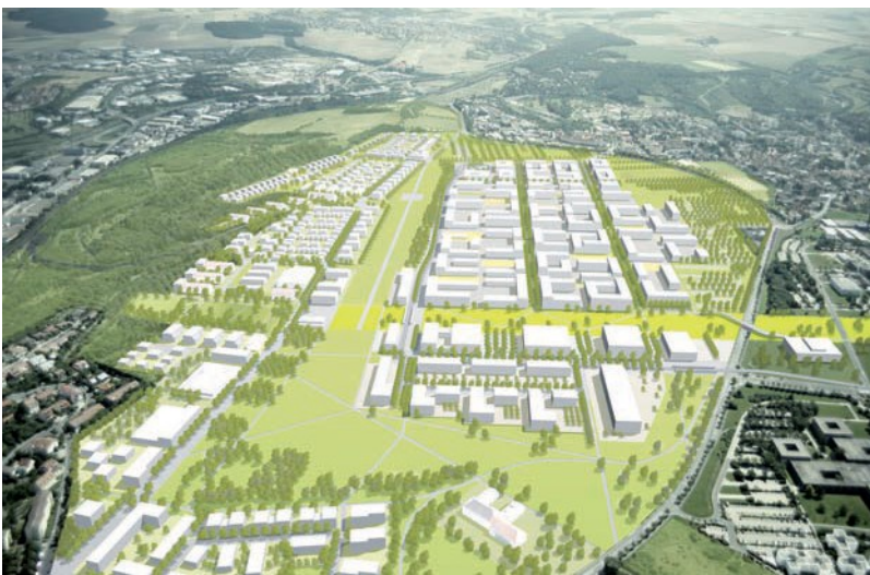
Die Leighton-Barracks waren bis 2009 der größte Militärstandort der US-Army in Würzburg. Auf dem Areal entsteht jetzt ein Stadtquartier mit Wohn- und Dienstleistungsnutzung, umfangreichen Grünflächen, sozialer Infrastruktur und Erweiterungsflächen für die Universität. 2018 findet hier die Landesgartenschau statt.
