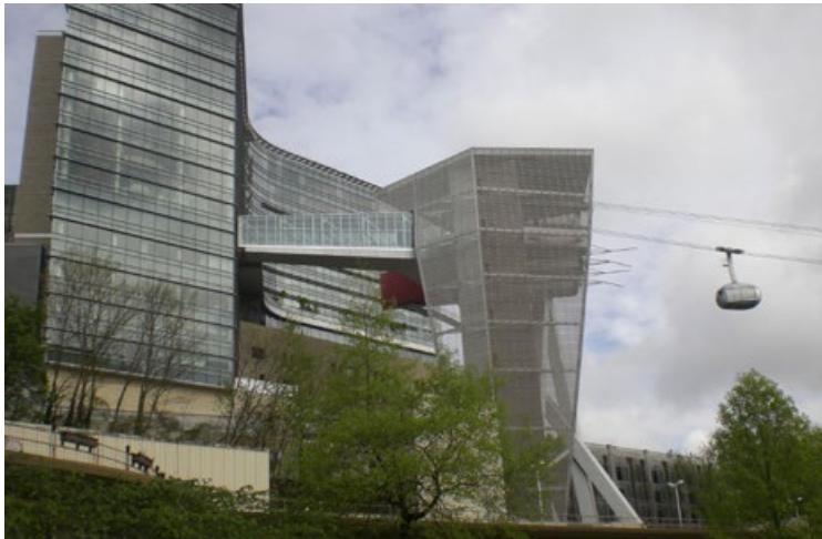
Bergstation der urbanen Seilbahn in Portland (Oregon), USA Quelle: Doppelmayr
