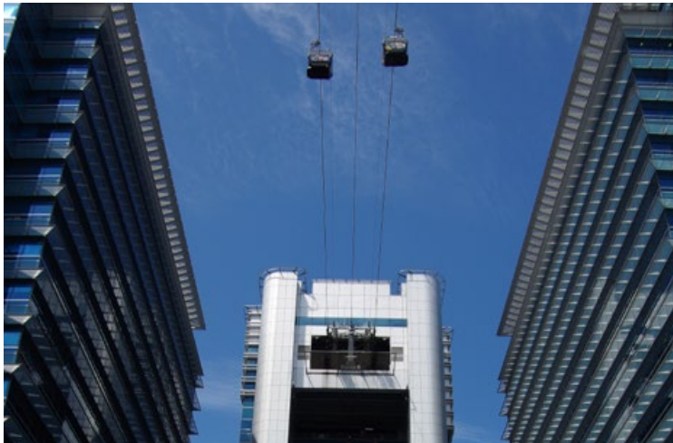
Station der urbanen Seilbahn in Singapur Quelle: Doppelmayr
