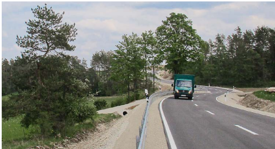
Einsatz einer Leitlinie (Mittelmarkierung) zur Verdeutlichung der Linienführung in unübersichtlichen Kurvenbereichen
