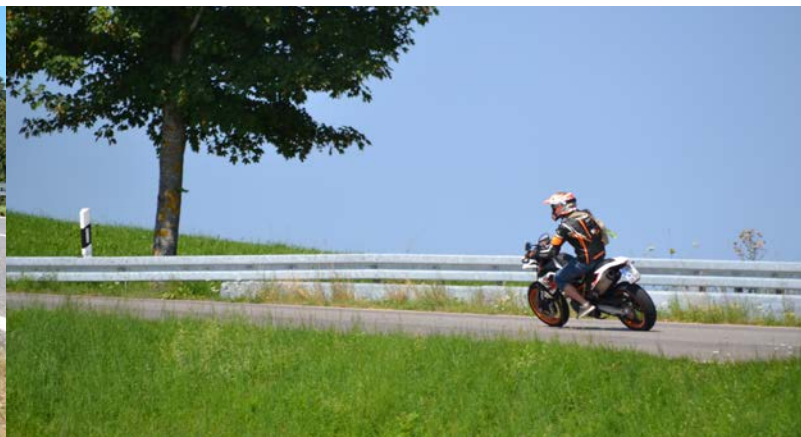
Unterfahrschutz zur Verminderung der Verletzungsgefahren für Motorradfahrer
