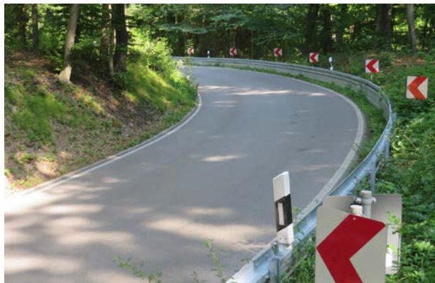
Aufgelöste Richtungstafeln zur Verdeutlichung des Kurvenverlaufs
