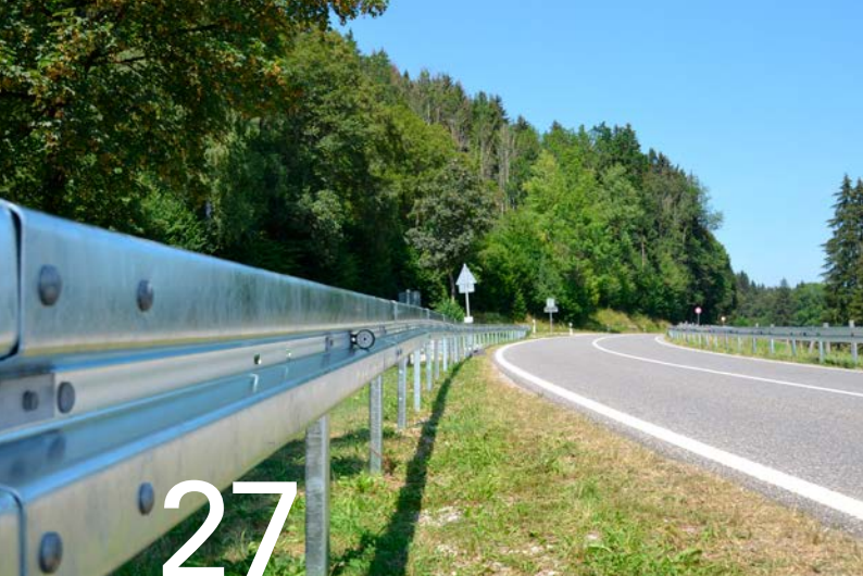
Fahrzeug-Rückhaltesysteme zum Schutz vor Aufprall auf gefährliche Hindernisse
