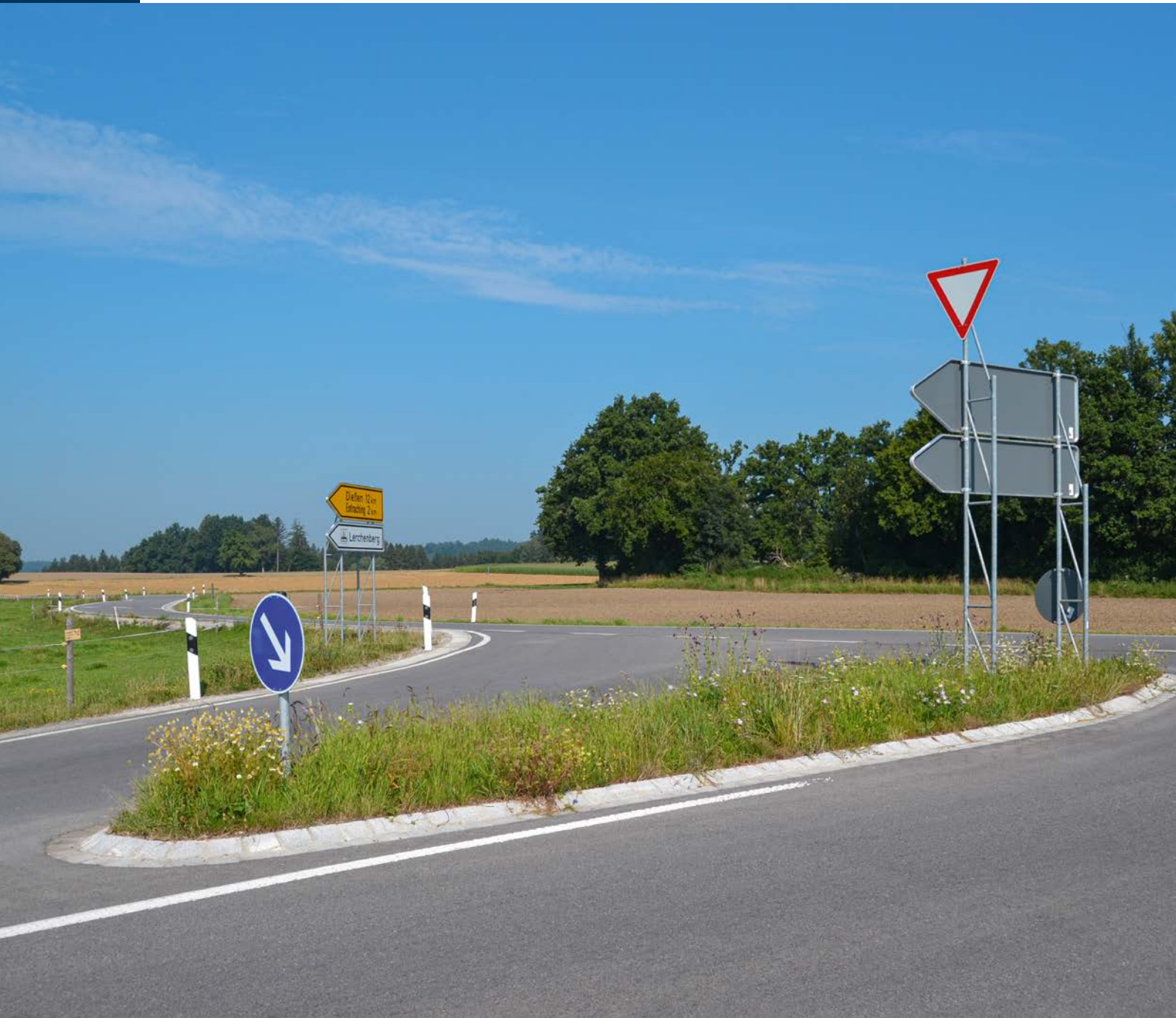
Verdeutlichung der Wartepflicht durch Einbau eines Fahrbahnteilers
