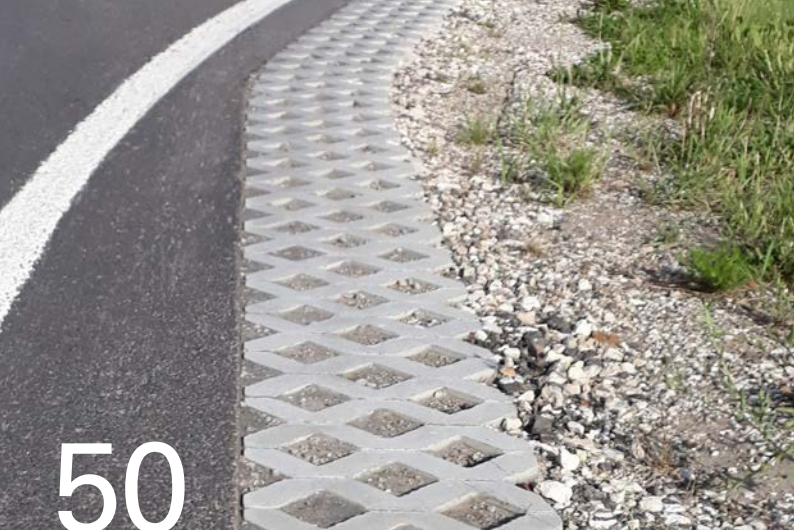
Bankettbefestigung aus Rasengittersteinen
