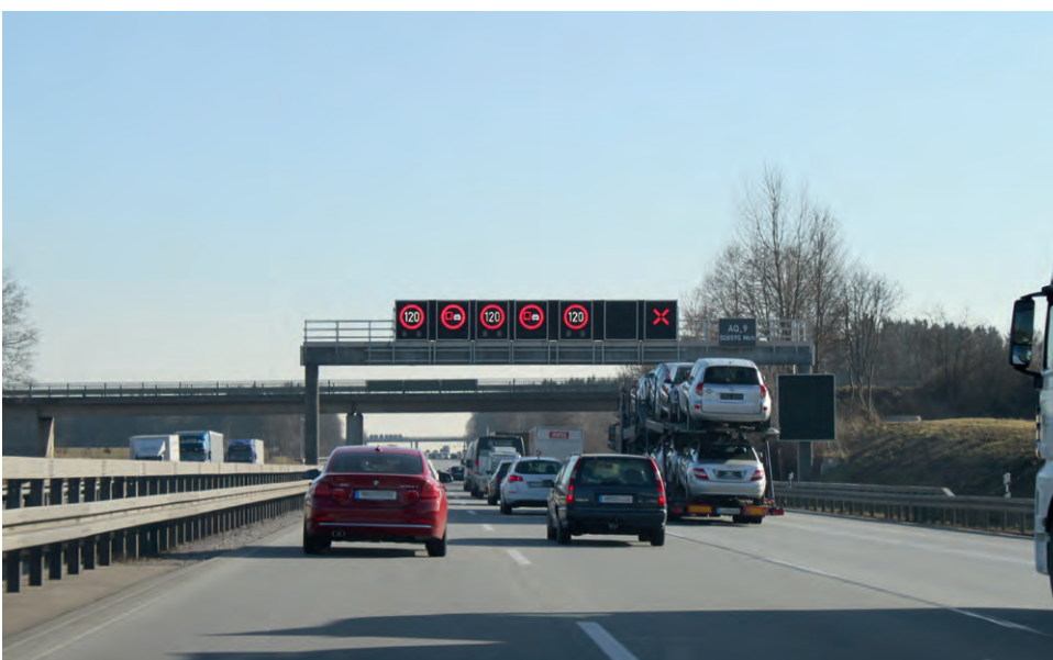
Geschwindigkeitsharmonisierung mit Lkw-Überholverbot auf der A9 zwischen der AS Allershausen und dem AK Neufahrn (Blickrichtung: München)
