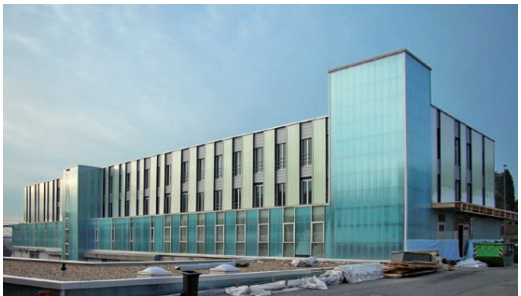
Abb. 08_03a und Abb. 08_03b: Energetische Sanierung und Umbau der städtischen Entsorgungsbetriebe in Remscheid. Durch die neue Fassade konnten Wärme- schutz und Gestaltung nach- haltig verbessert werden. [Quelle: Architektur Contor Müller Schlüter]
