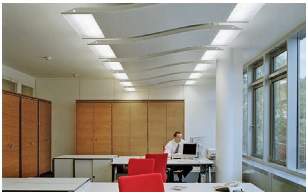
Abb. 05_02: Innenansicht eines Büroraums im Gebäude KfW-Ostarkade in Frankfurt (Projektsteckbrief: siehe Kapitel 9). Sturzfreie Fenster, eine geringe Raumtiefe, eine helle Deckenoberfläche und speziell geformte Deckensegel zur Lichtumlenkung tragen zu einer sehr guten Tageslichtausleuchtung des gesamten Raumes bei. [Quelle: Architekten RKW Rhode Kellermann Wawrowsky]
