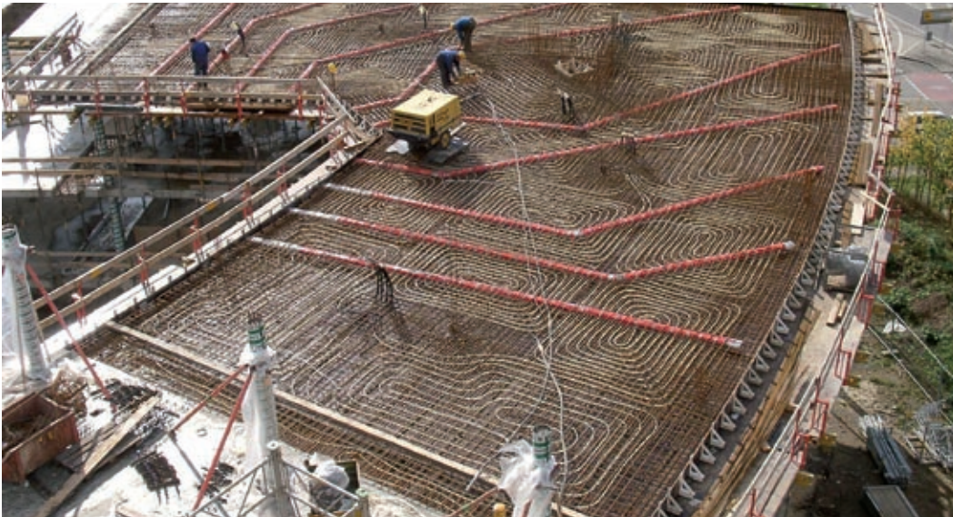
Abb. 04_07: Geschossdecke des Bürogebäudes Energon in Ulm vor dem Betonieren. Die Rohrschlangen werden an den Bewehrungsmatten fixiert und mit Wasser (oder Druckluft) zur Kontrolle der Dichtheit gefüllt. [Quelle: ebök Tübingen]
