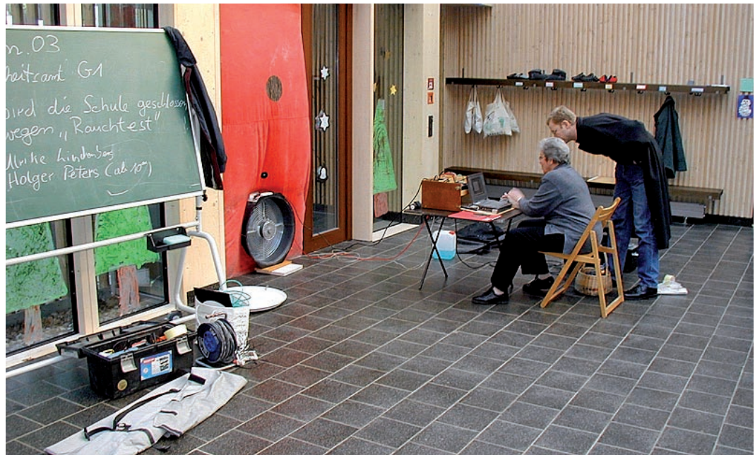
Abb. 03_01: Durchführung eines "Blower Door Tests" zur Untersuchung der Luftdichtheit der Gebäudehülle. [Quelle: www.luftdicht.de ]
