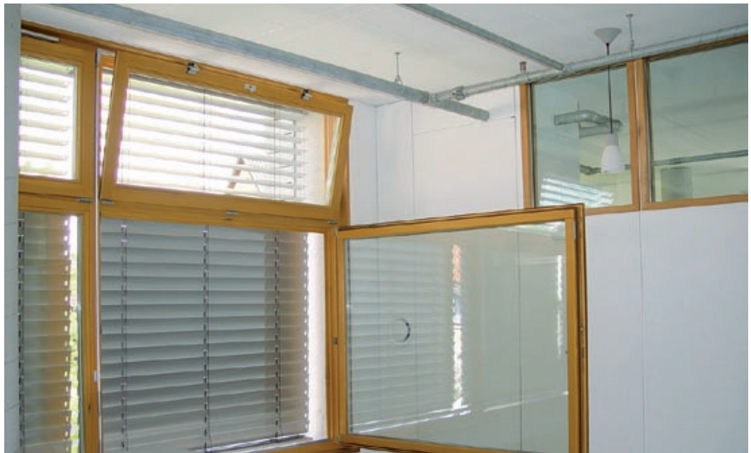
Abb. 04_04: Innenansicht des Sonnenschutzes im Bürogebäude Lamparter in Weilheim. Die horizontale Lamellenstellung im Oberlichtbereich sorgt durch Lichtumlenkung für eine ausreichende Tageslichtversorgung bei gleichzeitigem Sonnen- und Blendschutz. [Quelle: EnBau: MONITOR]
