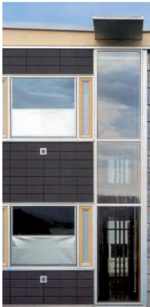
Abb. 05_04: Unterschiedliche Sonnen-/Blendschutzsysteme links: Horizontaljalousien – links oben der außen liegende Edelstahlbehang „s_enn“ der Firma Claussen, der durch sein Profil selektiv bestimmte Bereiche des Himmels ausblendet und dadurch eine gute Durchsicht erlaubt. Die Profilierung vermeidet Reflexblendung an den Lamellenoberflächen. Links unten die innen liegende „Genius-Lamelle“ der Firma Warema, deren Geometrie speziell auf die diffus reflektierenden Oberflächen abgestimmt ist. Dadurch wird eine gute Kombination von Sonnen-/Blendschutz und Durchsicht erreicht. [Quellen: Fa. Claussen Markisen, Fa. Warema] Rechts: Im Scheibenzwischenraum liegendes Rollosystem der Firma Agero am Gebäude der Firma Solvis in Braunschweig. Das beschichtete Rollo wird von unten nach oben zugefahren und gewährleistet somit bei aktiviertem Blendschutz noch Tageslichteintrag in den Raum im Überkopfbereich. [Quelle: Ortsmeyer, Braunschweig]
