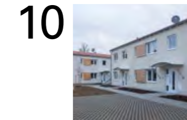
10 Staatliche Wohnanlage Straubing
