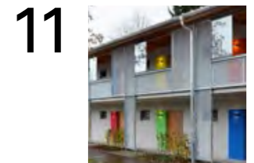
11 Wohnanlage Herzogsägmühle Peiting
