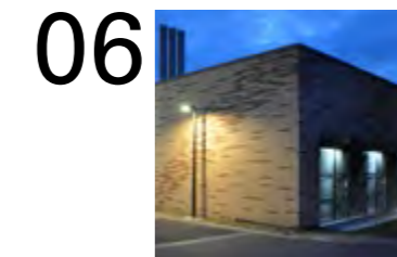
06 Energiezentrale Hochschule Aschaffenburg
