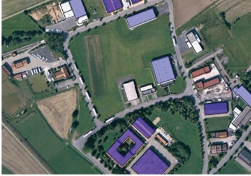
Beispiel Stadt Baunach Gebäudedächer größer 750 m 2
