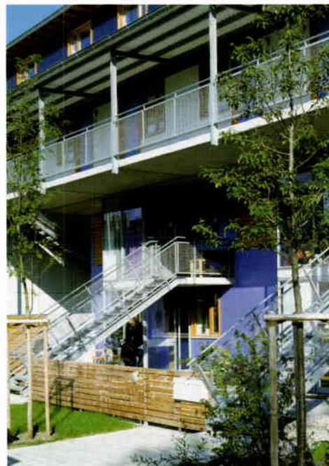
Geschosswohnungen an der Hartmannstraße, Erlangen; Kontrollierte Wohnraumbelüftung mit Wärmerückgewinnung; Architekten A2, Freising
