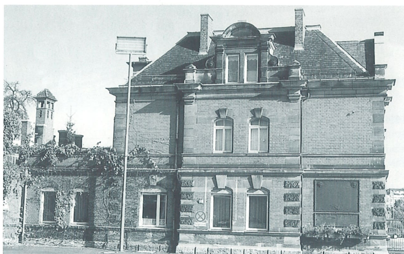
oben: Blick von der Rothenburger Straße auf den nördlichen Schlachthofbereich
