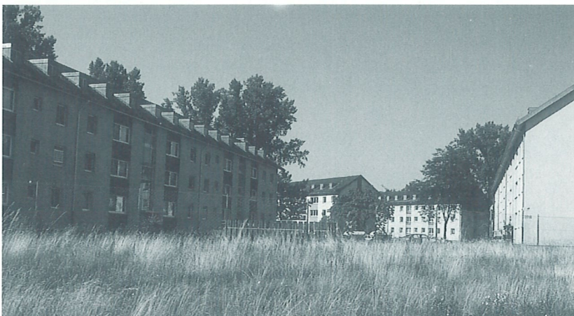
Ansichten der südlich angrenzenden Wohngebäude der Housing Area. Im Vordergrund das Planungsgebiet
