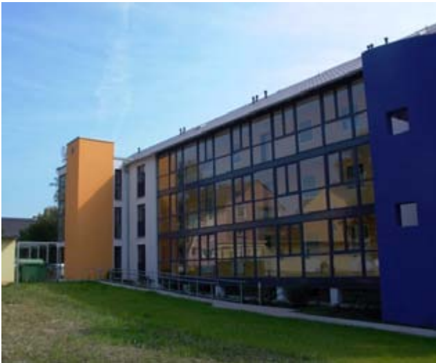
Impulsprojekt – Pflegestützpunkt in ehemaligem Wohnungsbestand
