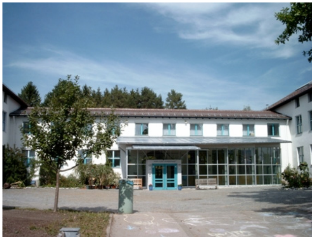
Einrichtung einer Schule im sanierten ehemaligen Unterkunftsgebäude
