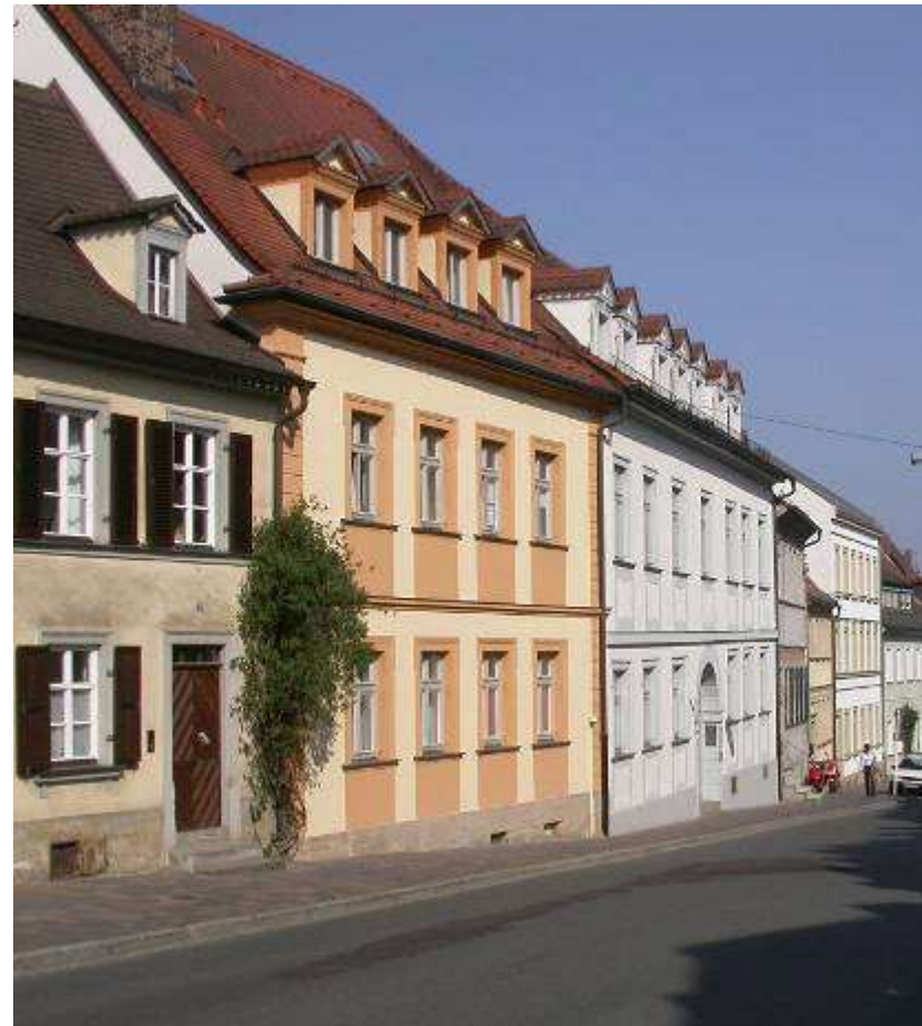
Fassadenansicht Straßenseite der beiden sanierten Gebäude (Mitte) (Foto: Kunigunden GmbH © Experimenteller Wohnungsbau)
