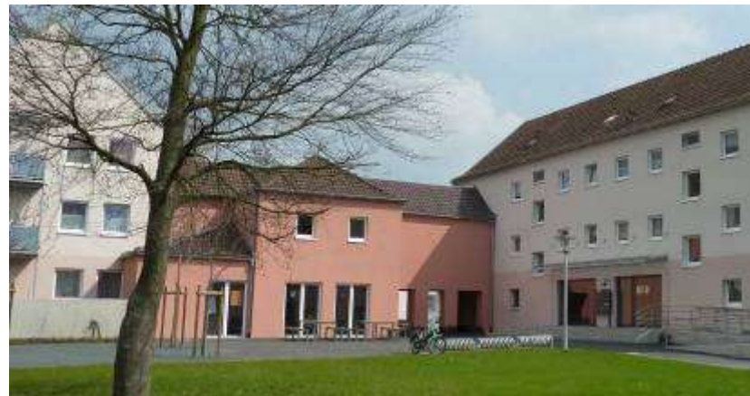
Erster Bauabschnitt, Zugangsseite (Foto: Oliver Seischab © Oberste Baubehörde)
