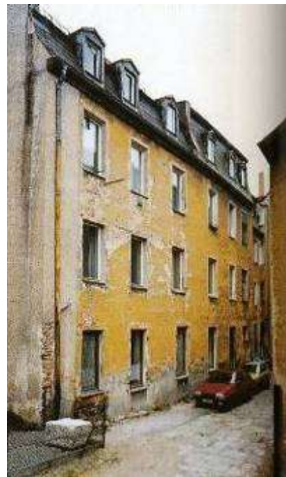
Vorher (© Experimenteller Wohnungsbau)
