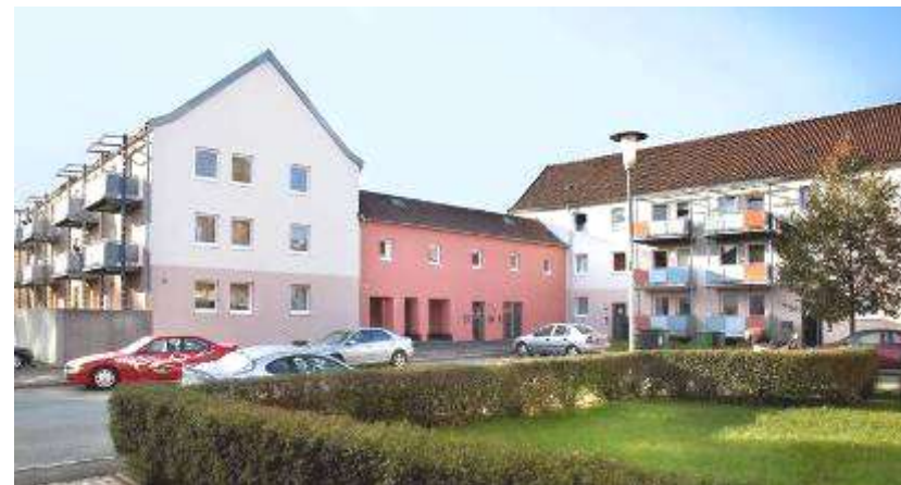
Erster Bauabschnitt, Zugang (Foto: Karin Sandeck © Experimenteller Wohnungsbau)
