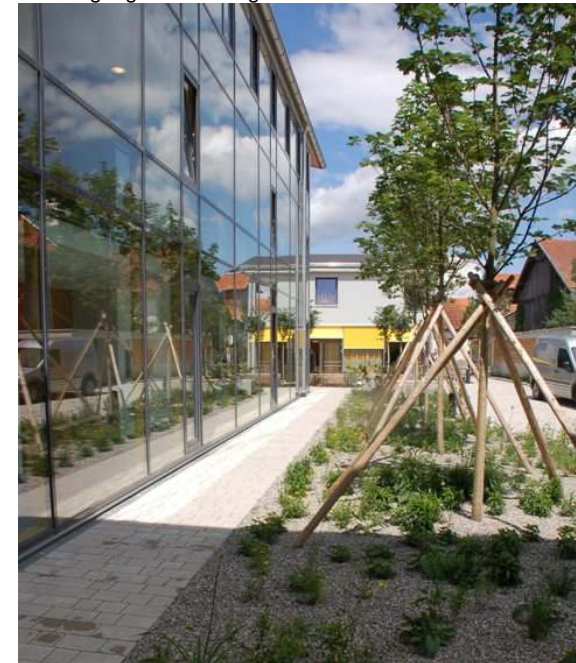
Verglaste, wettergeschützte Laubengerschließung
