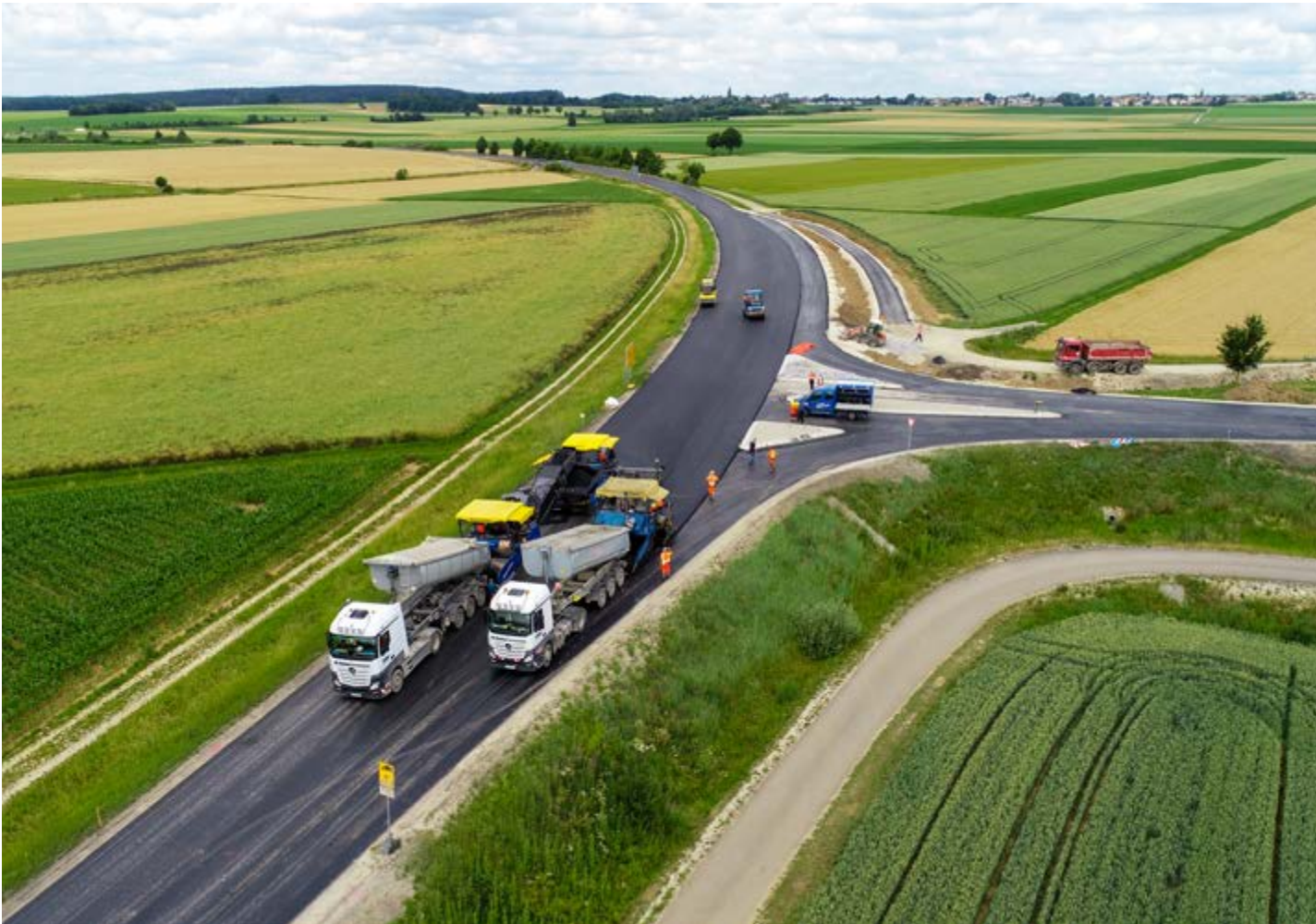
B 13, Fahrbahnerneuerung bei Eitensheim
