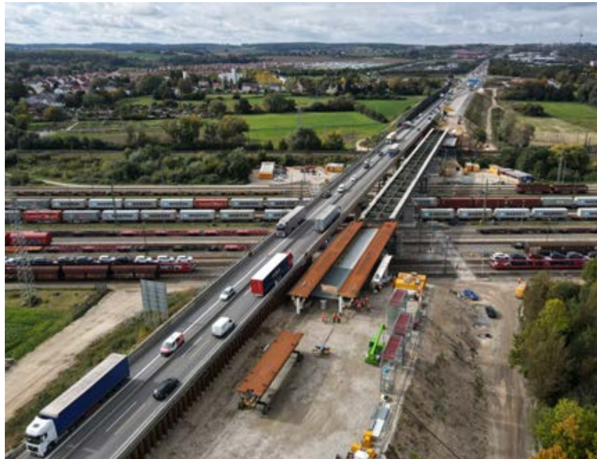
A 3, 6-streifiger Ausbau südlich Regensburg mit Neubau der Bahnbrücke Burgweinting
