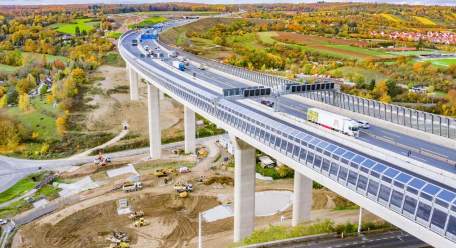
A 3, Talbrücke Heidingsfeld
