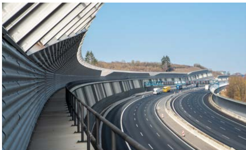
A 3, sechsstreifiger Ausbau bei Heidingsfeld mit umfassendem Lärmschutz
