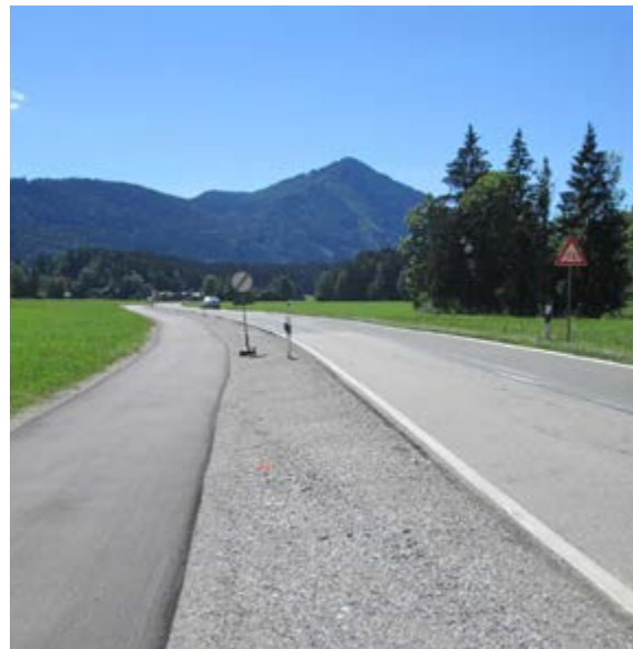
38 St 2072 Neubau Geh- und Radweg östlich Jachenau Staatliches Bauamt Weilheim Länge: 12,0 km Gesamtkosten: 6 Mio. € in Bau bis 2023
