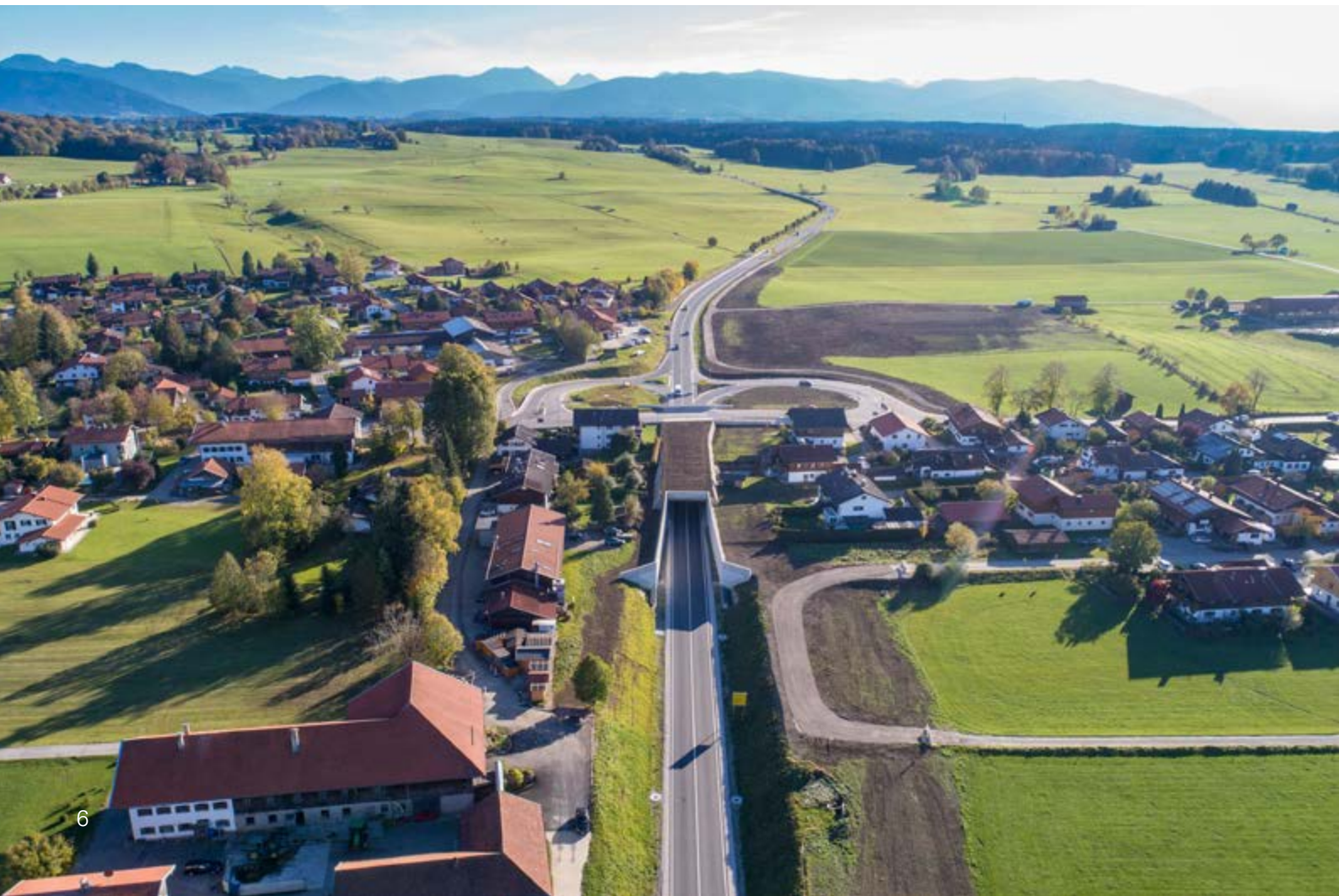
B 318, höhenfreier Umbau der Kreuzung mit der Kreisstraße MB 19 in Warngau
