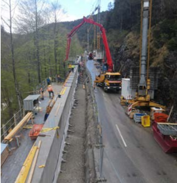
35 B 305 Erneuerung der Stützbauwerke Weinkaser (Deutsche Alpenstraße) Staatliches Bauamt Traunstein Länge: 0,5 km Gesamtkosten: 9,2 Mio. € Fertigstellung 2021
