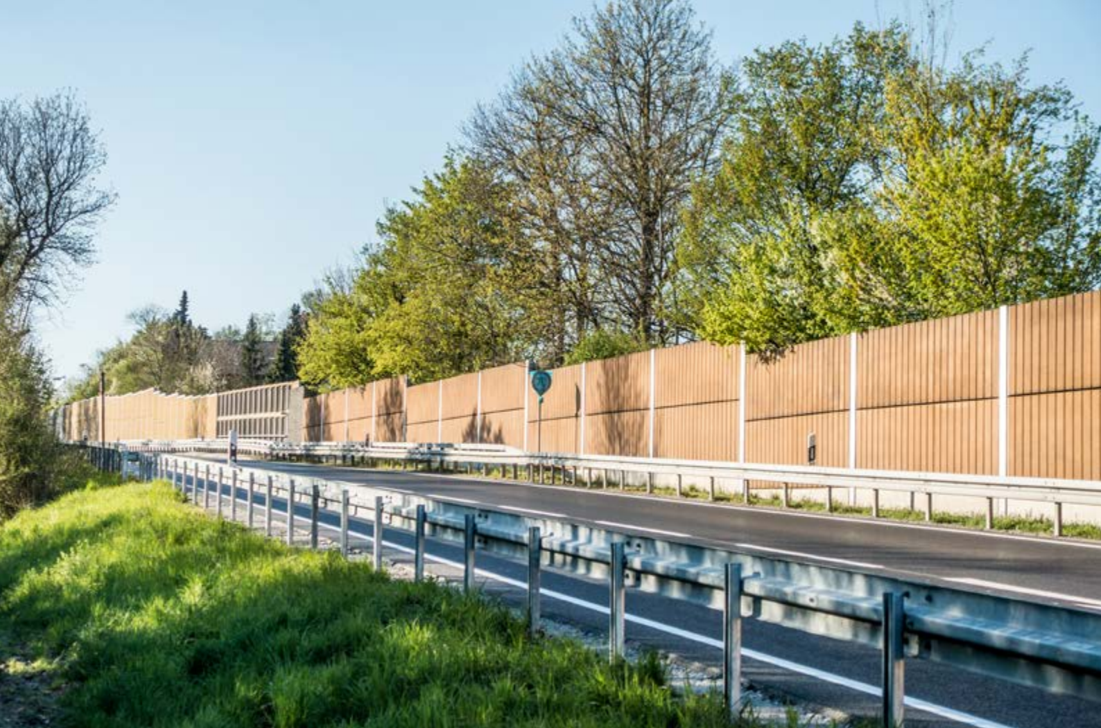
Reduzierung des Verkehrslärms durch eine Lärmschutzwand
