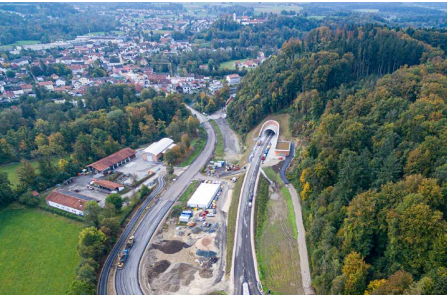
B 304, Aubertunnel im Zuge der Ortsumgehung Altenmarkt a.d. Alz und Nordportal des Tunnels in der Detailansicht
