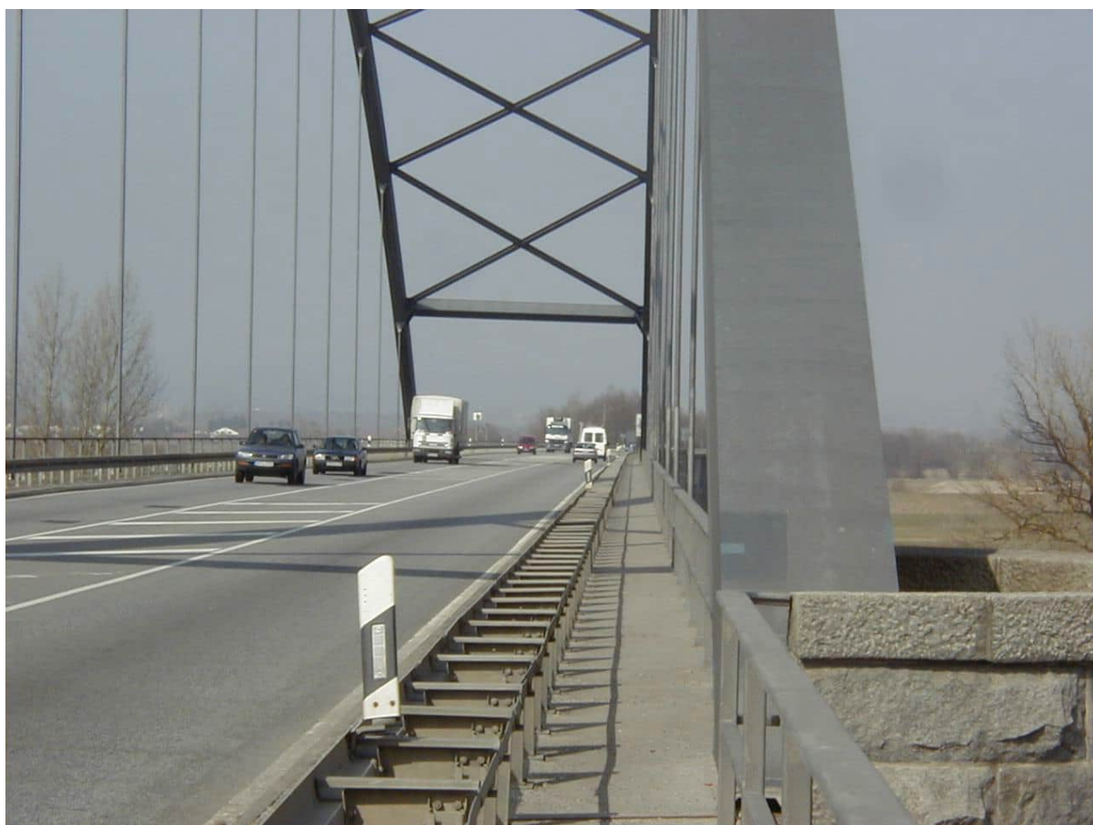
Abbildung 5 Bogen mit abgehängter Fahrbahn.
