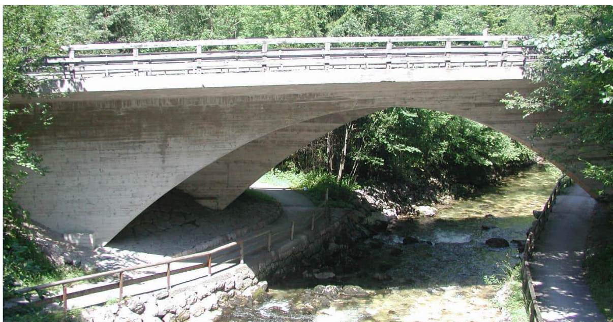
Abbildung 8: Brücke mit Bogenscheiben aus Stahlbeton
