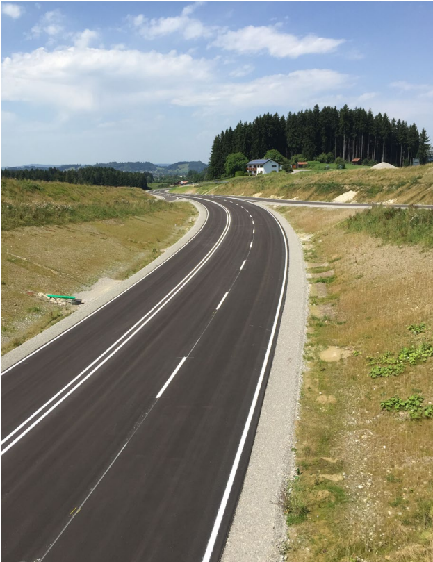
➤ B 472, Ortsumfahrung Hohenpeißenberg; Trasse im Bereich Anschlussstelle Hohenpeißenberg West
