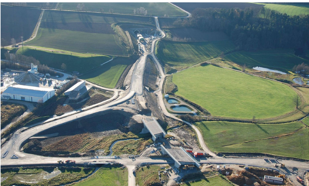
« B 20, Ortsum- gehung Furth im Wald, Portal des Deschlberg-Tunnels mit Anschlussstelle Furth-Mitte
