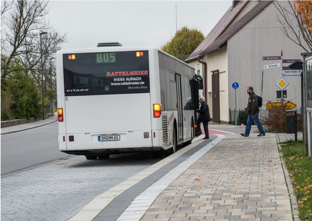
« Bushaltestelle mit Kasseler Hochbord und taktilen Bodenelementen
