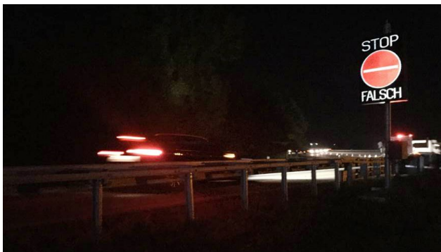
≡ A 9 Falschfahrerwarnsystem
