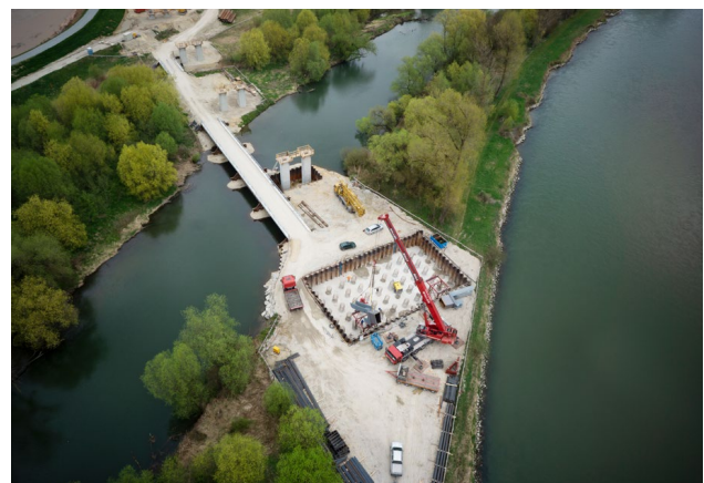
➤ St 2124, Ortsumgehung Plattling, Neubau der Isarbrücke mit Einheben der ersten Stahlteile am Kämpferfundament
