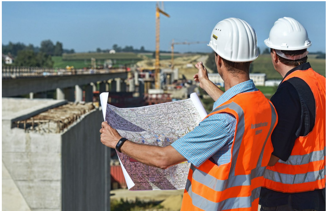
» A 94, Bauleitung auf einer Autobahnbaustelle
