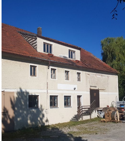
Bild links und Titelseite: Sanierung und Umbau des Pfarrstadels in Lohkirchen vorher und nachher
